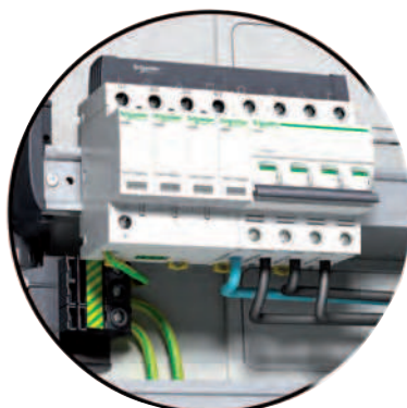
Ogranicznik przepięć 4P + iC60N 4P
